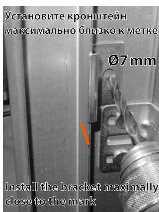
Усиление верхнего ролика Top roller reinforcement
